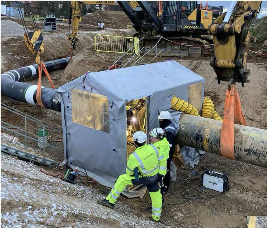
De sidste svejsninger er udført, og den nye gasledning er gået i drift. Foto: Energinet
